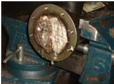
Intercambiador de Calor con acumulación de Sarro.
