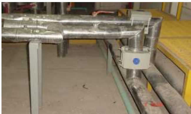
Modelo FF201 instalado en la entrada y a la salida de la torre de enfriamiento.
